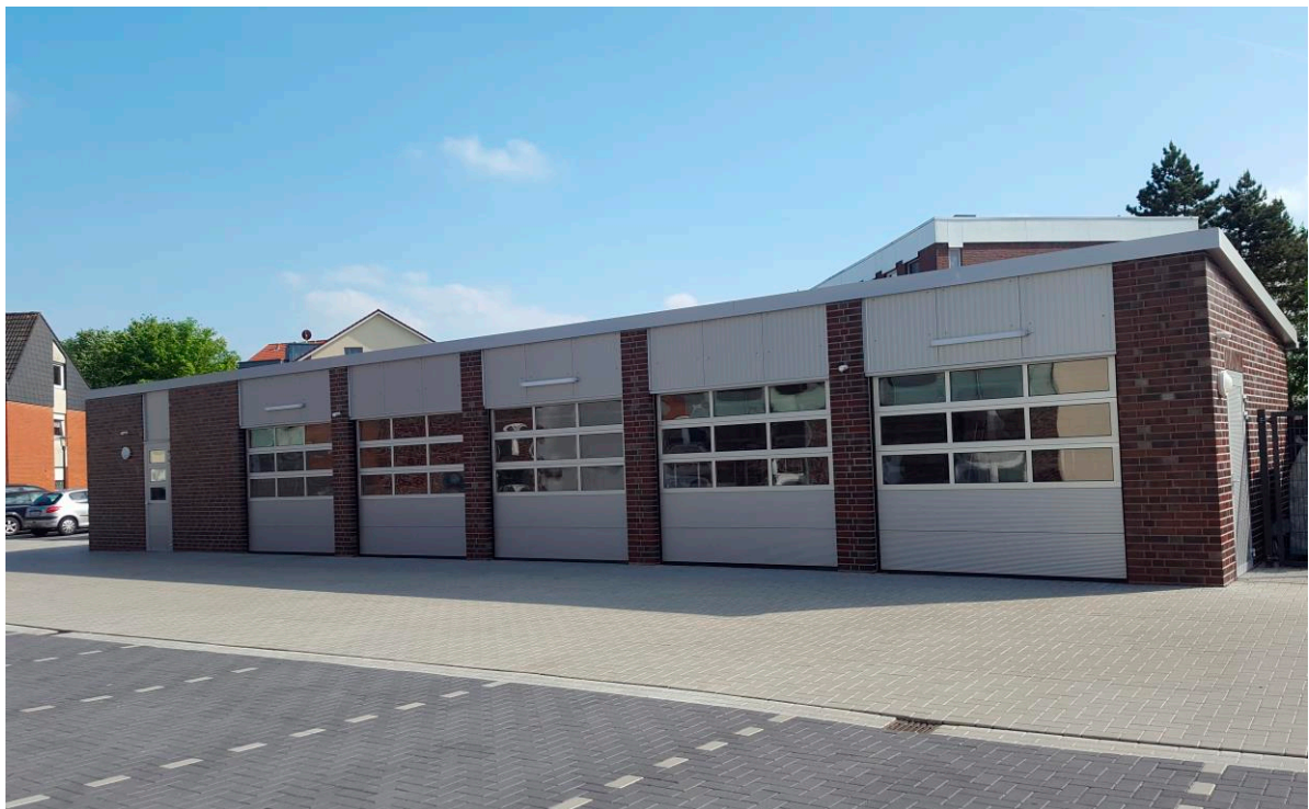
Nebengebäude mit Fahrradabstellraum und Fahrzeug- und Lagerflächen für die Instandsetzungswerkstatt.
